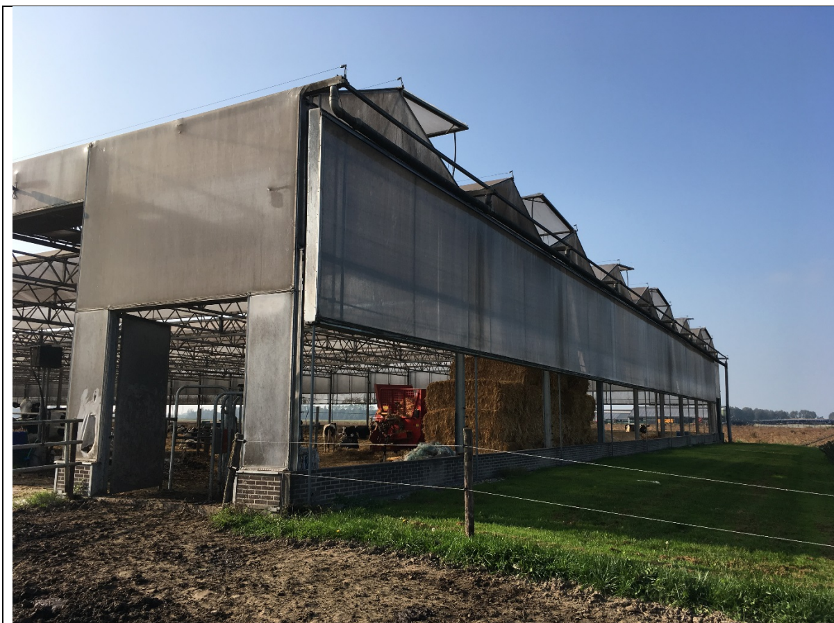
Billede 17: Facader udføres om gardiner, enten som rullegardin som vi kender det i Danmark eller som hele plader, der køres op og ned beklædt med polyesterprodukt. Samme beklædning kan bruges på gavle.
