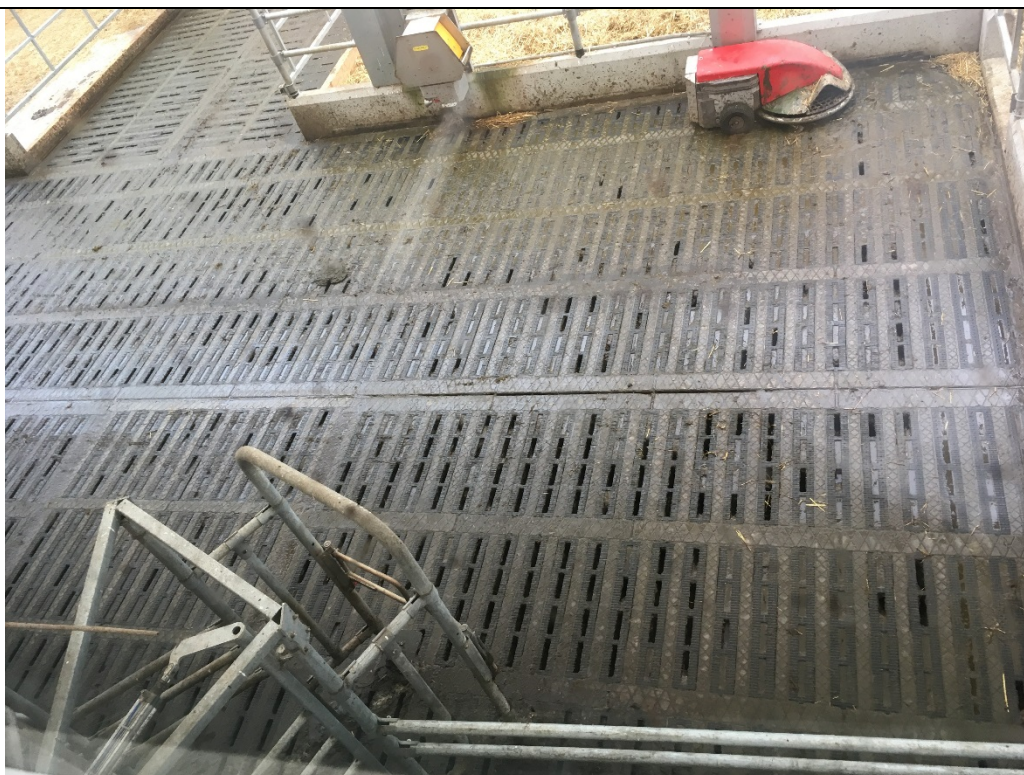
Billede 16: Spaltegulv med fleksibel lukning ned mod gyllekanalen
