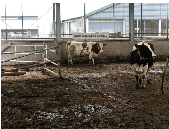
Billede 25 og 26. Billedet til venstre viser, hvorledes det var tiltænkt at permeabelt gulv skulle fungere, og billedet til højre viser virkeligheden efter nogen tids brug. Foto: Dairy Campus, Wageningen.
