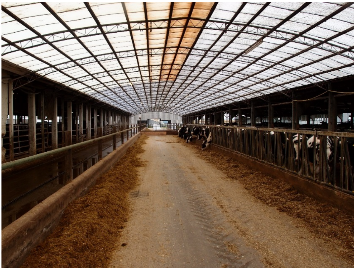
Billede 18: Model II, foderbordet udføres som et fast betongulv eventuelt drænet. Renholdes med robot.
