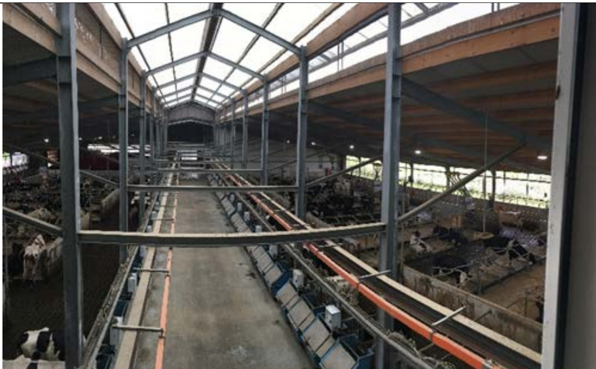
Billede 20: Søjler placeret ved overgange mellem foderbord og staldarealet
